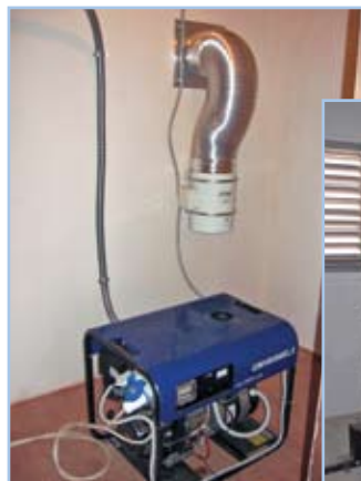
Монтаж электростанции GMH8000ELX
