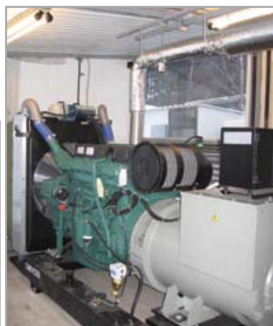
Монтаж электростанции GMH8000ELX
